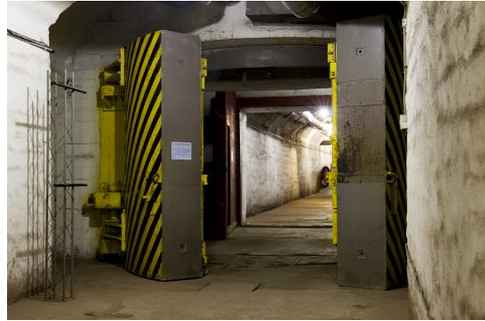
**vyrábí a renovuje** protitlakové a plynotěsné dveře, poklopy a uzávěry. Ty se navrhují s protitlakovou odolností od 200 KPa a vyšší. Dveře a poklopy vyrábíme i v balistických odolnostech FB4/BR4, FB6/BR6, TBO3, TBO6 dle ČSN 395360.
